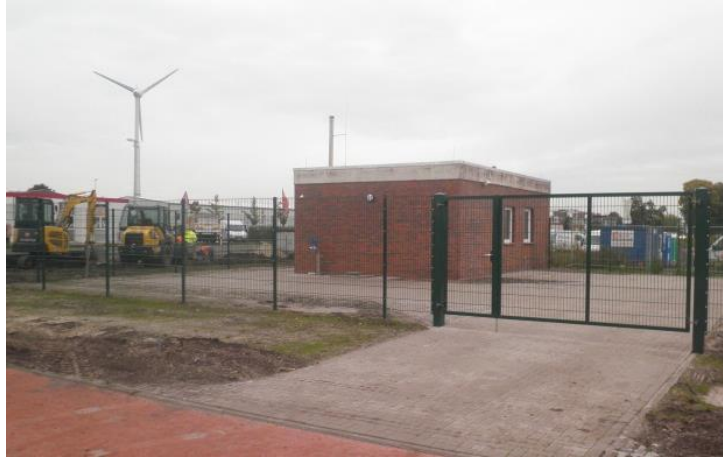
Pumpwerk Dornumer Straße
